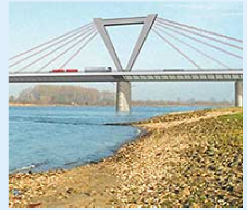
Rheinbrücke Düsseldorf Ilverich, plate from Dillinger Hütte
